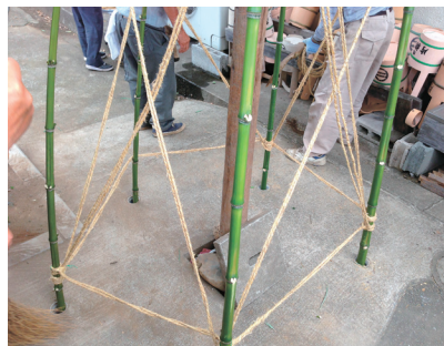
竹の立て方・縄の結び方 (写真3)
